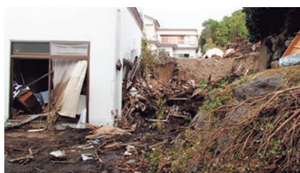
土石流は河口部まで流れ、下流でも大きな被害が出た
